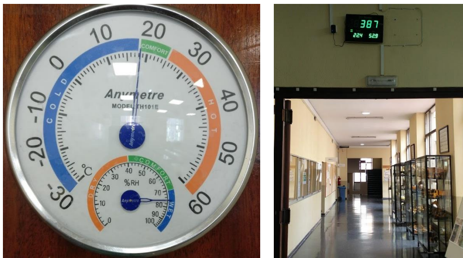
Imagen 6.- Sensores de temperatura y humedad. Medidor de dióxido de carbono.
